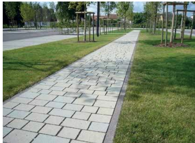
betonstraatstenen met verbrede voeg
