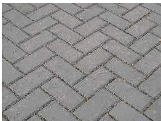
betonstraatstenen met drainage-openingen
